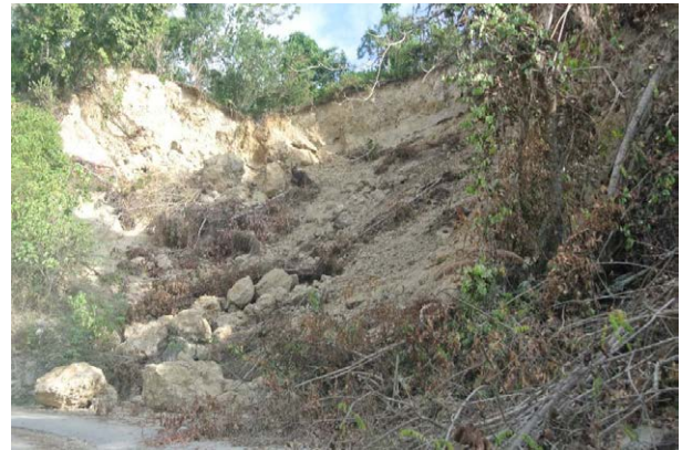
Tanah runtuh di sepanjang jalan menuju Donggala Barat.
